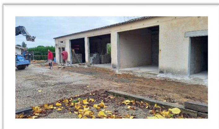
Début des travaux
