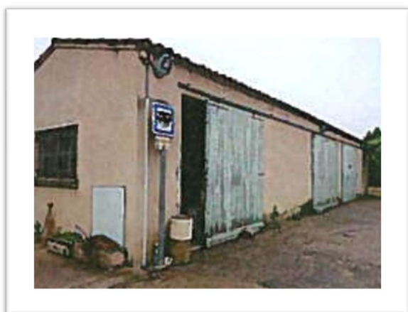
Les ateliers avant travaux
